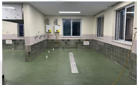
신평고등학교 급식실 공사 관급자재
