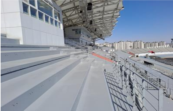
이순신종합운동장 관중석바닥 방수공사
