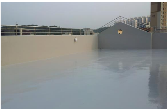
이인초등학교 지붕 방수공사
