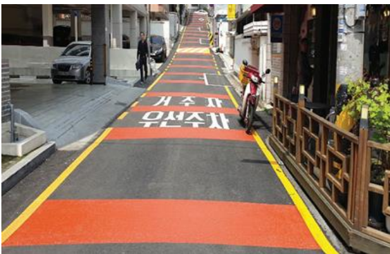
박찬호 기념관 진입도로 개선공사 관급자재
