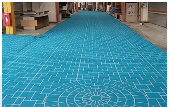
청양 봉암도로 포장도 보수공사 관급자재
