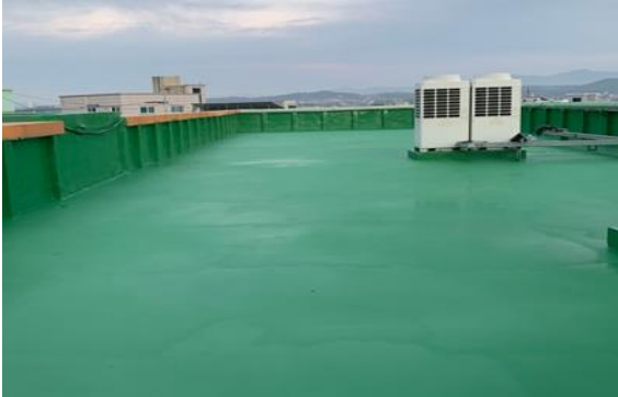
대전오류초등3교 옥상방수공사 관급자재
