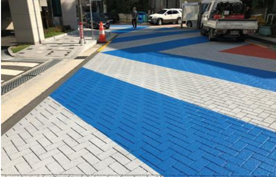
서천 계동리 인도 및 배수로 정비 공사/도막형바닥재
