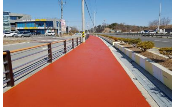
금학동지구 자전거도로 유지보수 공사
