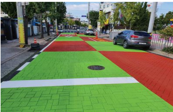
부여 지방도613호 금천도로 마을주민 보호구역 설치공사
