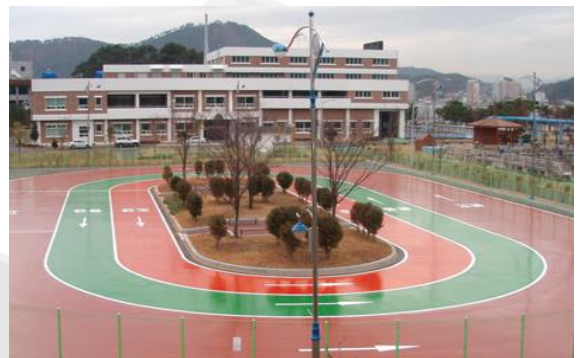
송석초 놀이 및 휴식공간 탄성 포장공사
