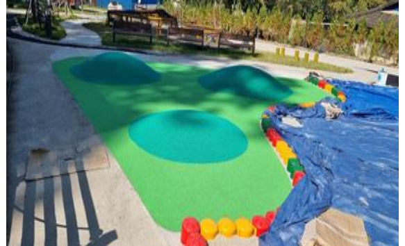
추부초 어린이놀이시설탄성 포장재 설치 관급자재 구입
