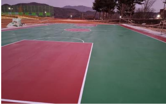
목천고등학교 진입로 확장공사 체육시설탄성포장재 구입
