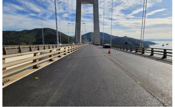
금산 지방도601호 군북로 포장도 보수공사
