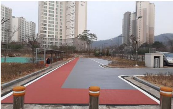
교동지구 자전거도로 유지보수 공사
