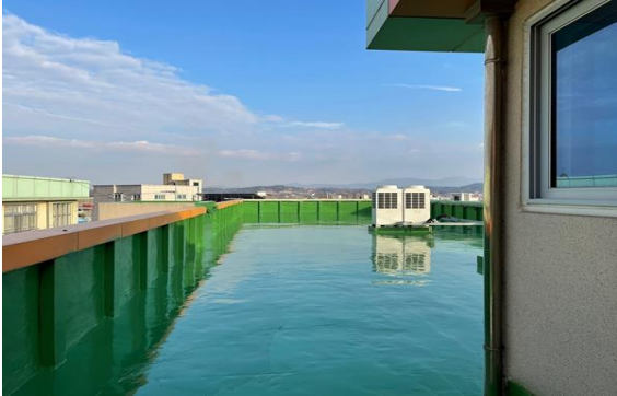
호계초등학교 다목적강당 지붕방수공사
