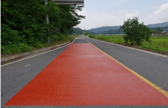
부여 지방도625호 장암지구 미끄럼방지시설 설치
