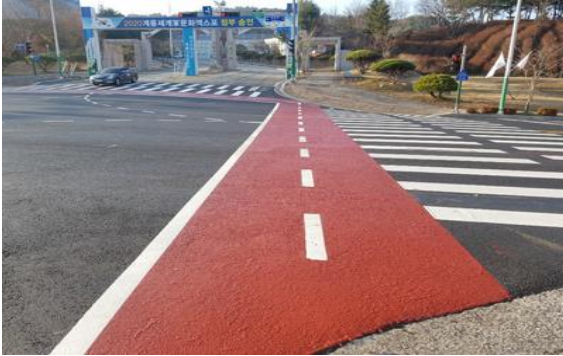
신관동지구 자전거도로 유지보수 공사
