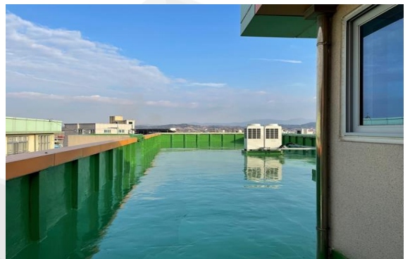
공주중동초등학교 교사 방수공사
