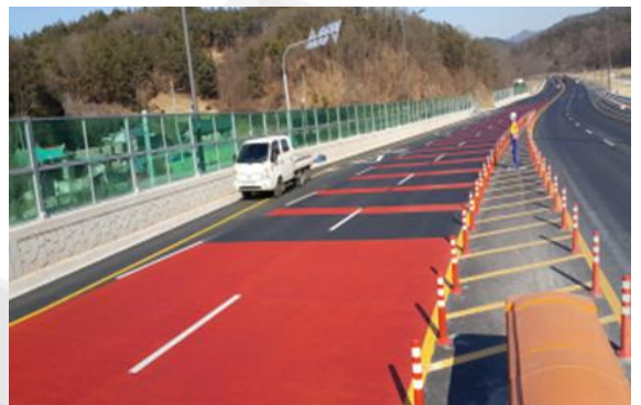
청양 봉암도로 포장도 보수공사 관급자재
