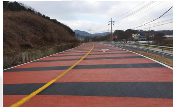
지방도623호 선인교 보수보강 공사 관급자재 구입
